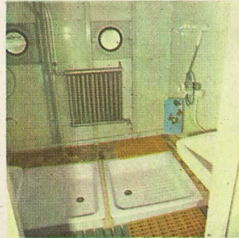
Duschraum in einem schwimmenden Hotel A.C.R.
